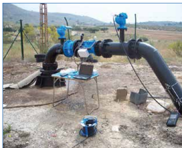
Tomada de datos de caudal y presión a la salida de un pozo
